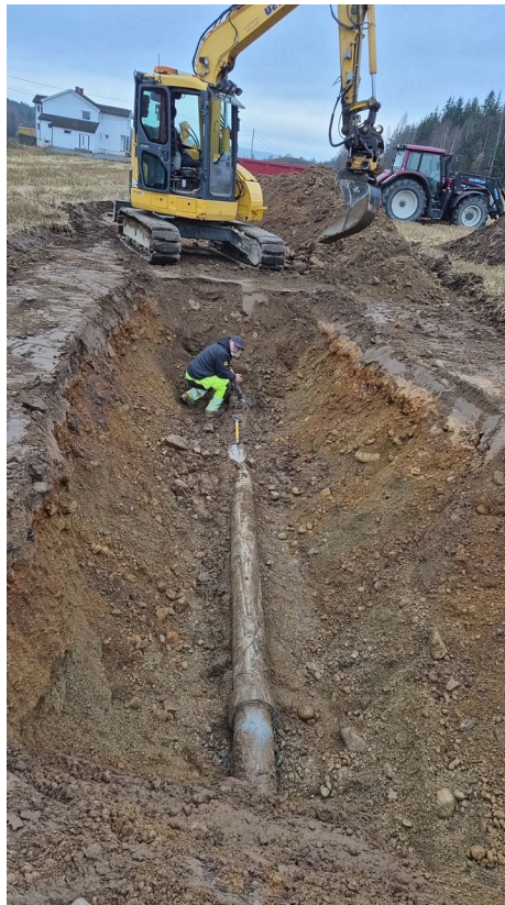
Reparasjon etter vannlekkasje, vår 2024
